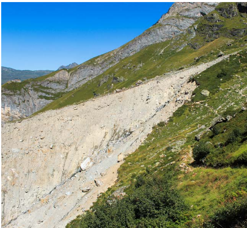
Glissement de terrain
