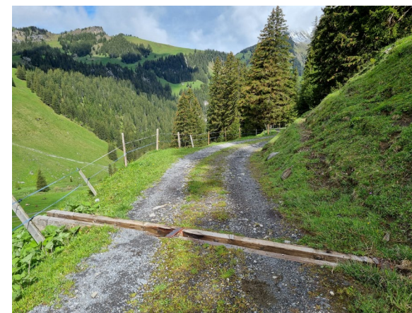
Positivbeispiel: gut unterhaltener Querabschlag zur Entwässerung
