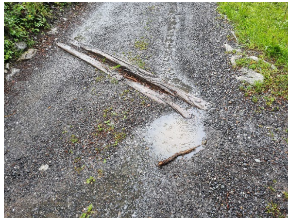
Verstopfte und defekte Querabschläge
