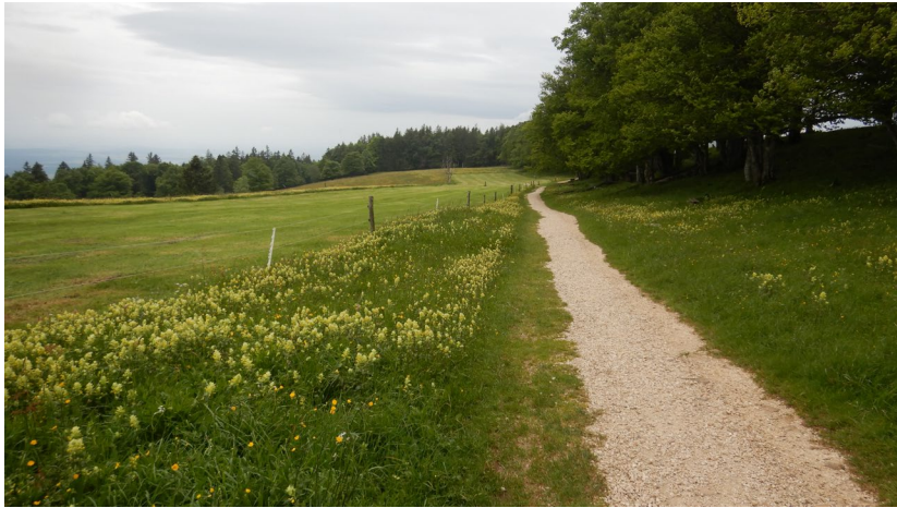
Überdimensionierte Verbreiterung und Ausbau des Wegtrassees
