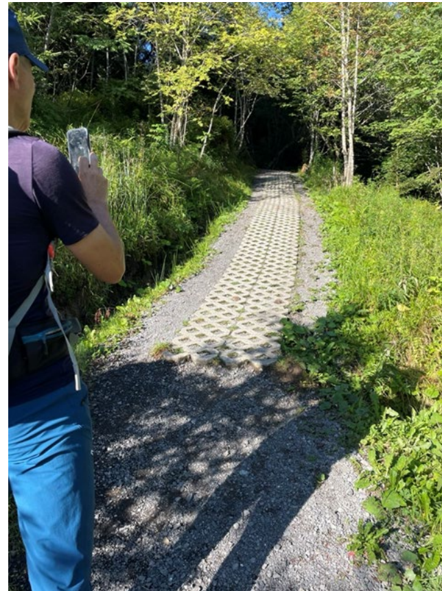
Eingebaute Rasengittersteine gelten ebenfalls als Hartbelag
