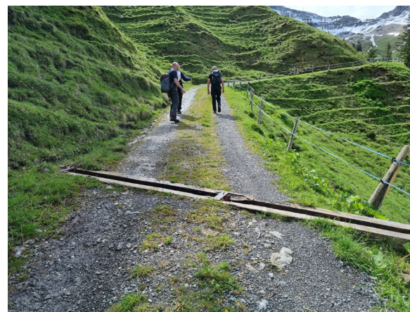
Positivbeispiel: gut unterhaltener Querabschlag zur Entwässerung
