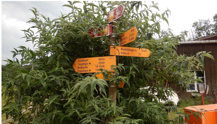
Schlechte Sichtbarkeit der Wegweisung, da Vegetation nicht zurückgeschnitten wurde resp. Wegweiserstandort nicht an einem optimalen Ort gewählt, da Vegetation sehr schnellwüchsig ist.
