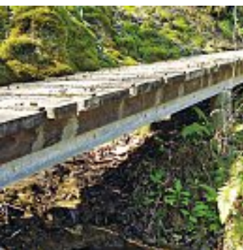
Fig. 51 Surface de marche en planches brutes de sciage
