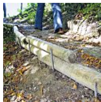
Fig. 22 Bordure simple
