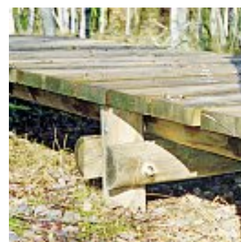
Fig. 52 Passerelle sur pilotis
