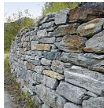
Fig. 82 Mur en pierres sèches
