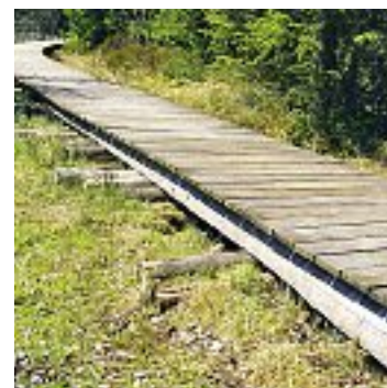
Fig. 53 Passerelle sur poutres transversales
