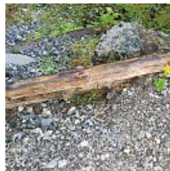
Fig. 88 Bordure détériorée
