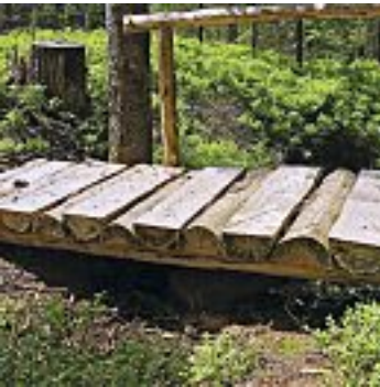
Fig. 50 Surface de marche en demi-rondins
