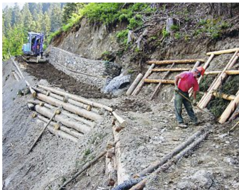
Fig. 81 Stabilisation d'un talus avec des caissons en bois (à gauche), des gabions (au fond) et un treillage (à droite).
