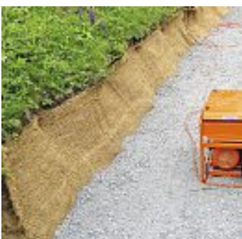
Fig. 76 Les nattes de jute protègent le talus pendant les travaux contre l'érosion
