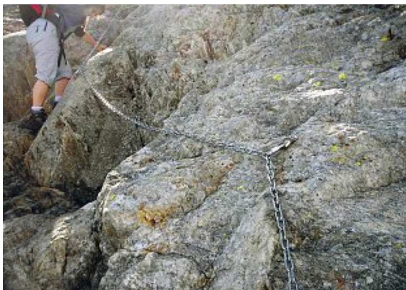
Fig. 63 Main courante en chaîne galvanisée
