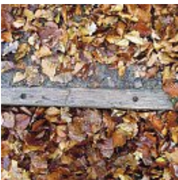
Fig. 56 Marche avec percements pour les fers d'armature
