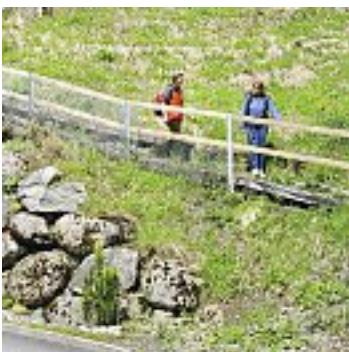
Fig. 62 Balustrade en bois
