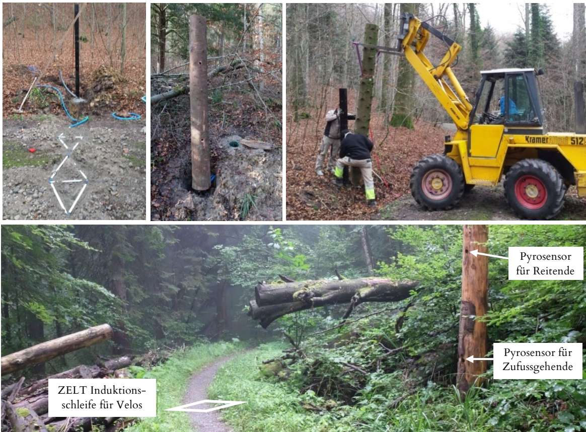
Abbildung 10: Oben: Installation eines Multizählers mit Veloschleifen, sowie Pyrosensoren zur Erfassung von Zufussgehenden & Reitenden: Bild unten: gleiches Zählgerät in Betrieb (Fotos: Ronald Schmidt, Wildnispark Zürich)
