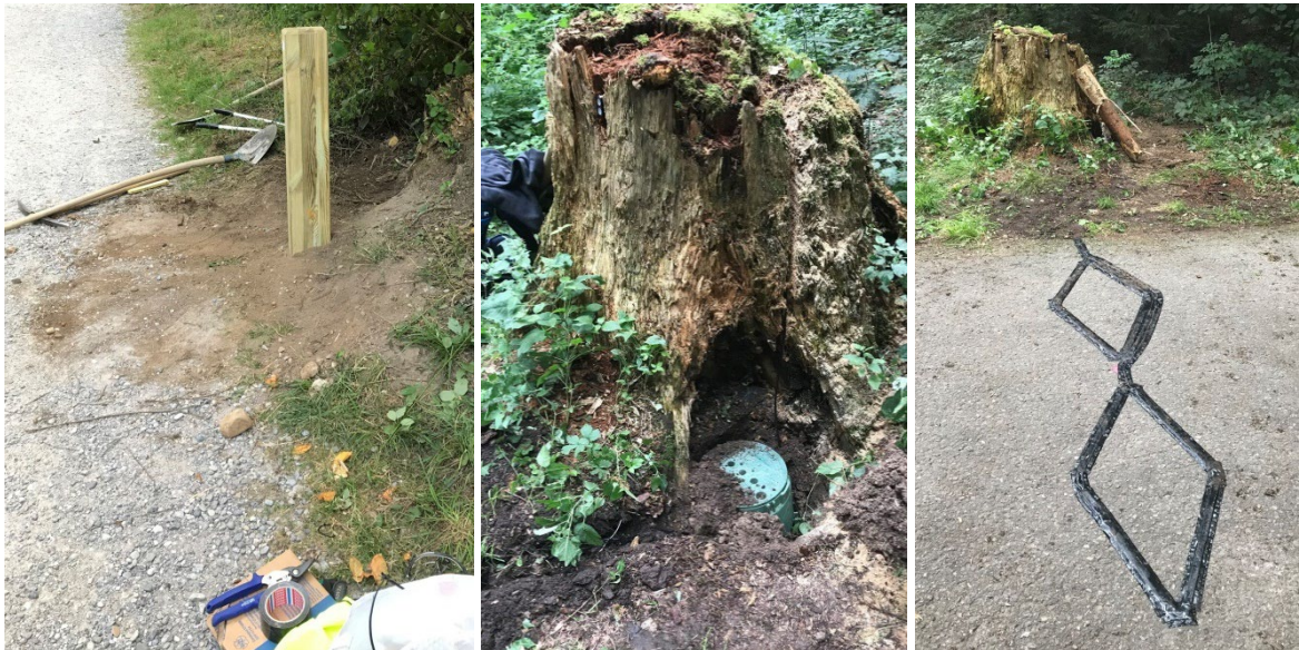
Abbildung 33: Einbau eines Eco-Multi (links) bzw. Easy ZELT mit PYRO Sensor (Mitte & rechts)
