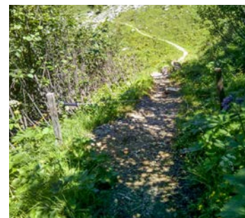
Passaggio in recinzione con maniglia isolante scarsamente visibile perché all'ombra di vegetazione spontanea
