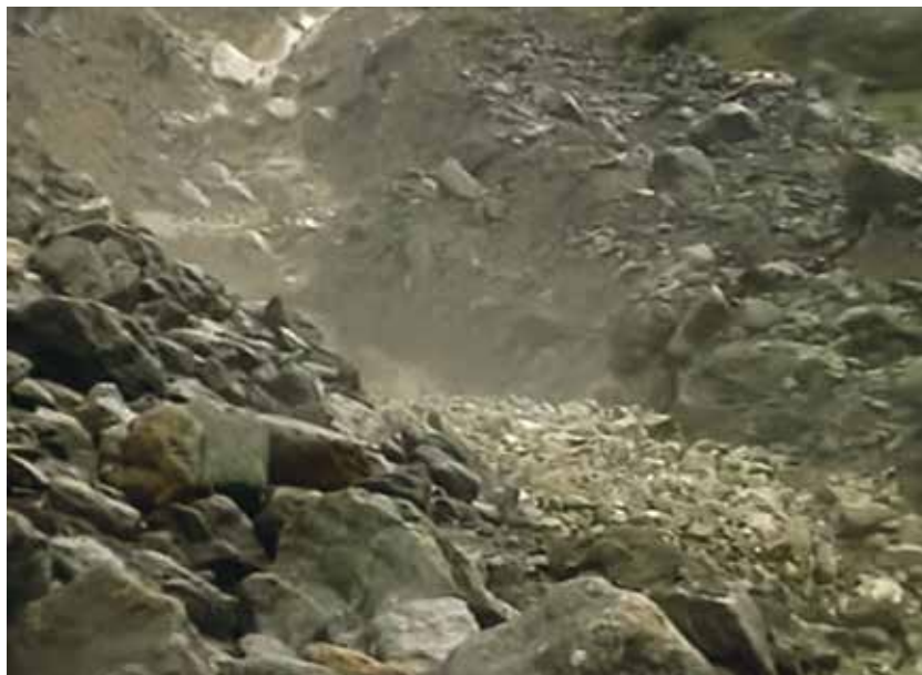
Fossato con colata detritica sul sentiero alpino Bäregg-Schreckhornhütte (Grindelwald).
